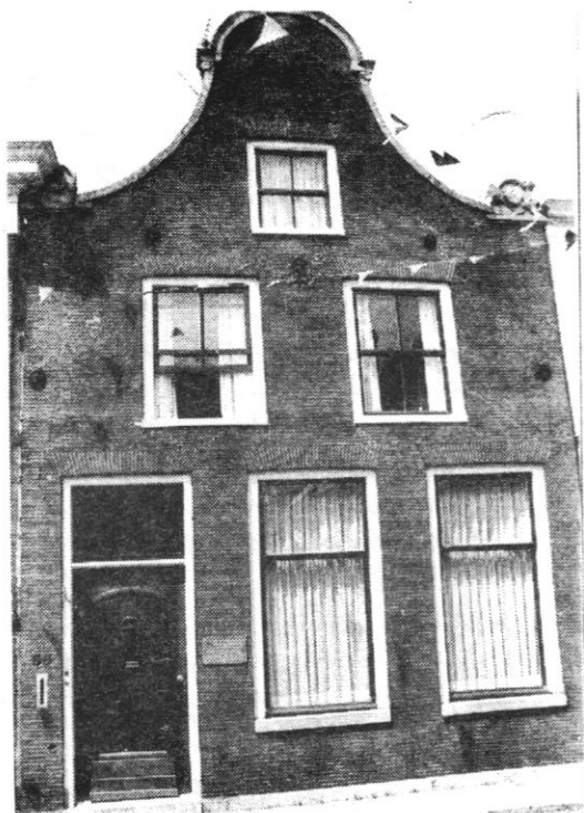
de pastorie in de Kerkstraat, welke aanvankelijk dienstdeed als kerkgebouw
